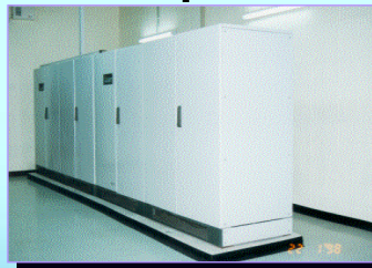
3x500 KVA UPS
